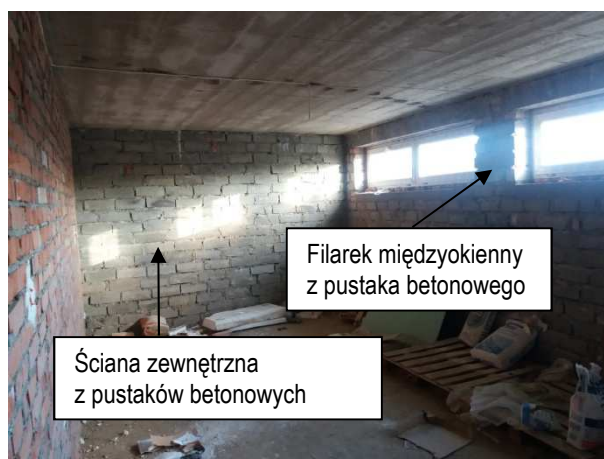
Fot.2 Widok na ścianę zewnętrzną w projektowanym pomieszczeniu aneksu kuchennego
